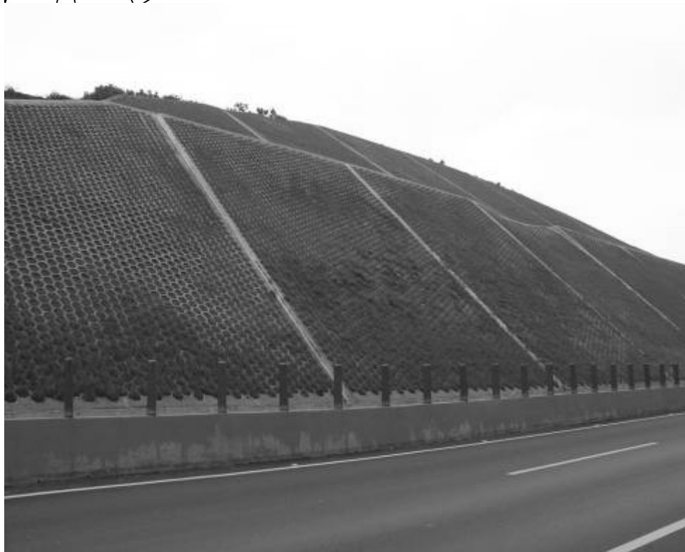
混凝土六方块护坡
