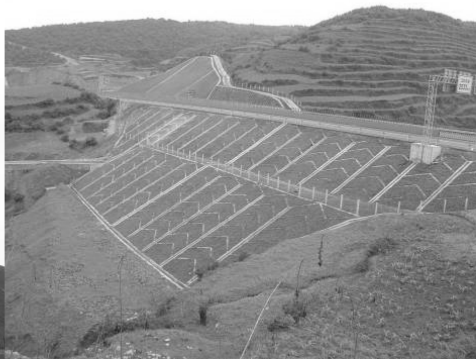
混凝土网格植草护坡
